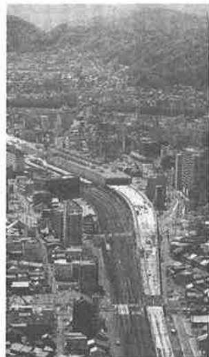
新大詰めを迎えている福井駅周辺の再開発。新しい駅舎の骨格がほぼ出来上がっている。
