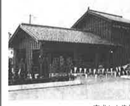
完成した漁村文化伝承館
