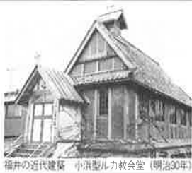
福井の近代建築 小浜聖ルカ教会堂(明治30年)
