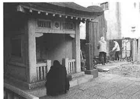
解体工事前の実測調査 （手前が套堂。奥に景岳橋本君碑が見える）
