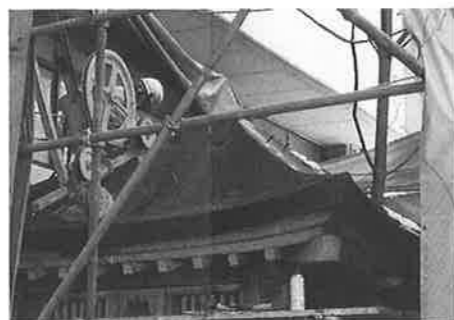
解体工事作業風景
